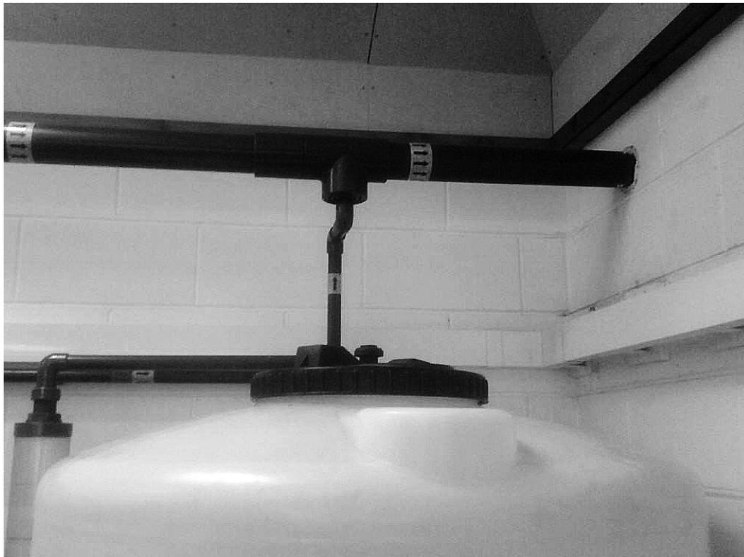
Рис. 17 Правильный способ установки тройника Вентури
