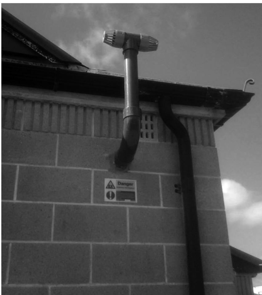
Рис. 20 Точка безопасной вентиляции
